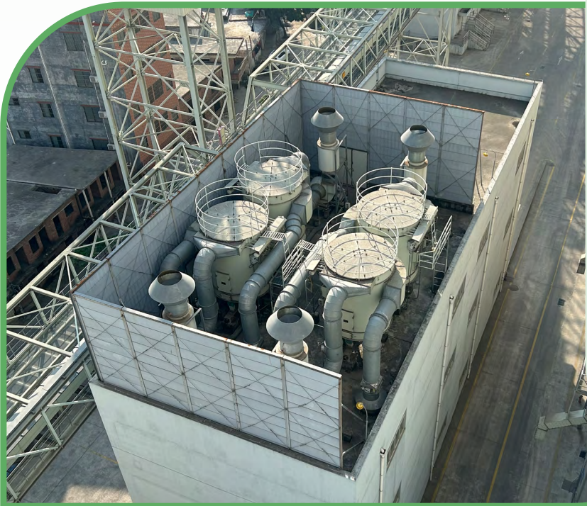
◇ 东莞物流降噪工程
